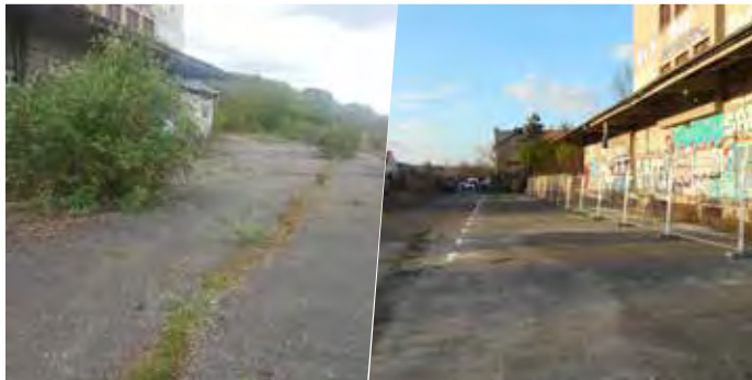
Terrain avant/après aménagements
