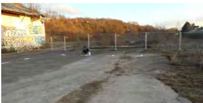
Marquage en cours
