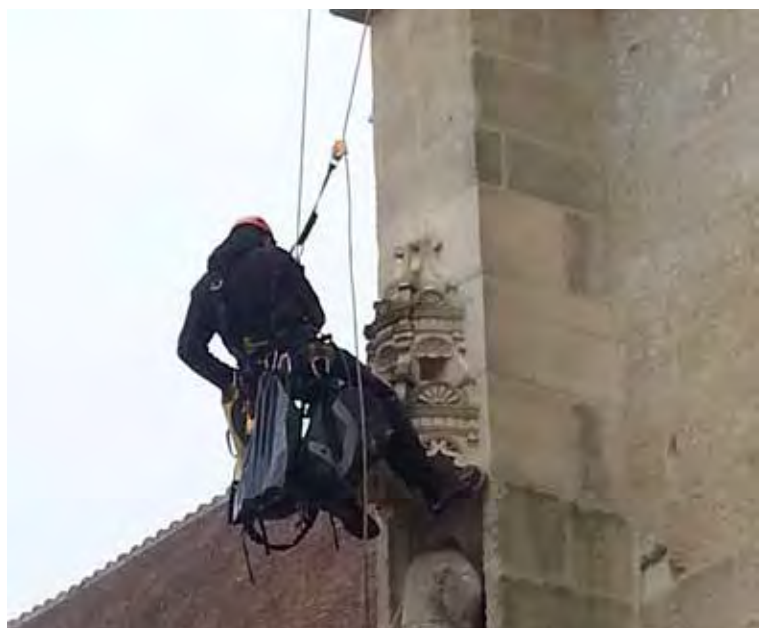
Installation du traitement
