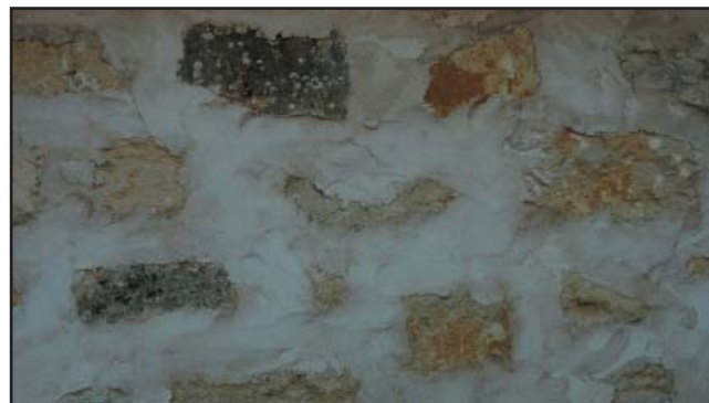
Joints des maçonneries dits «à fleur de pierre».
