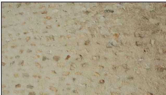
Enduit «beurré» sur maçonnerie traditionnelle
